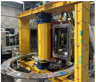
図. 解体の様子
